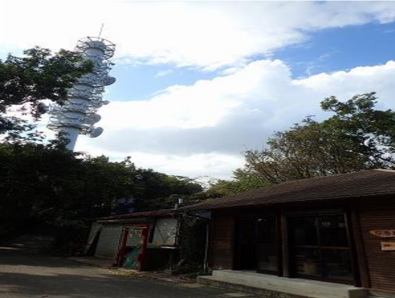
電波塔は貴重なランドマークです。
